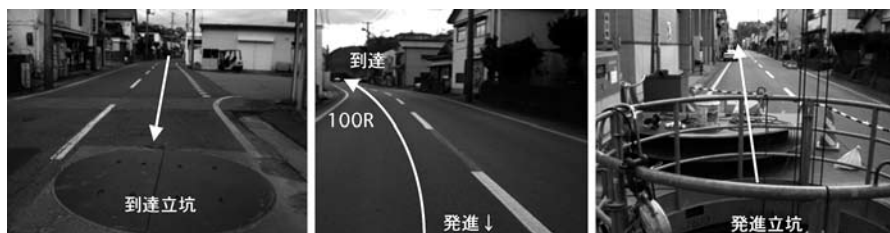
写真-2 発進・到達立坑状況
