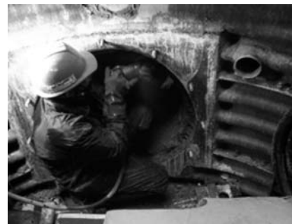
写真-5 坑口部の削孔状況 (膨張材併用)
