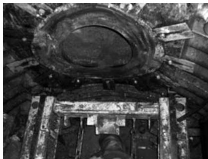
写真-4 発進立坑 (坑口部) の状況
