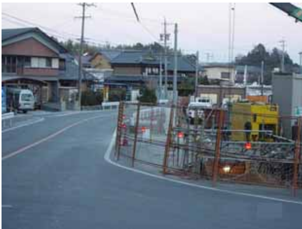
写真 - 4 発進立坑部の状況
