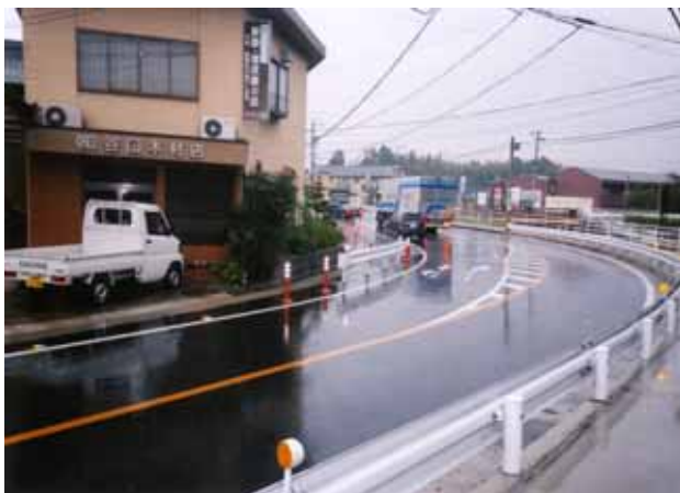
写真 - 1 80R 曲線部
