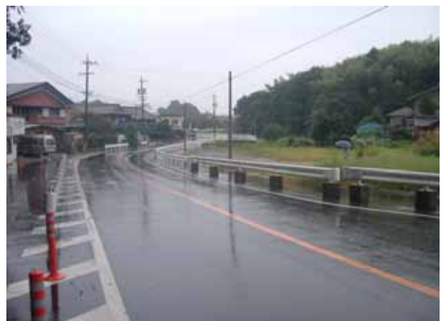
写真 - 2 100R 曲線部
