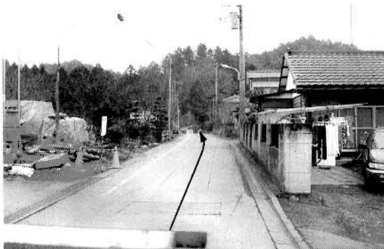
写真2 施工現場状況
